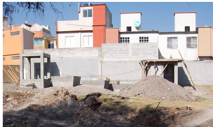
Fig. 1. Obra de construcción de la planta de tratamiento de aguas residuales
